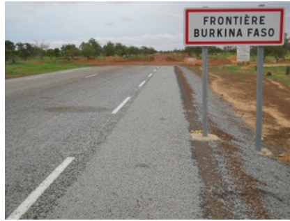
Construction de routes bitumées
