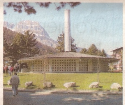
Autre particularité de Vouilloux : la chaufferie centrale est collective.
