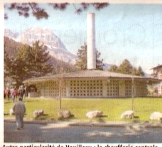
Autre particularité de Vouilloux : la chaufferie centrale est collective.
