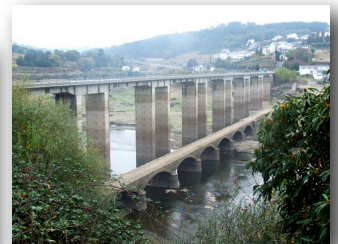
Le barrage à vide permet de voir l'ancien pont
